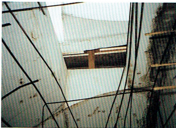
Bild 5: Unterschiedlich dicke Styroporsegmente im Kopfbereich der Skulptur
