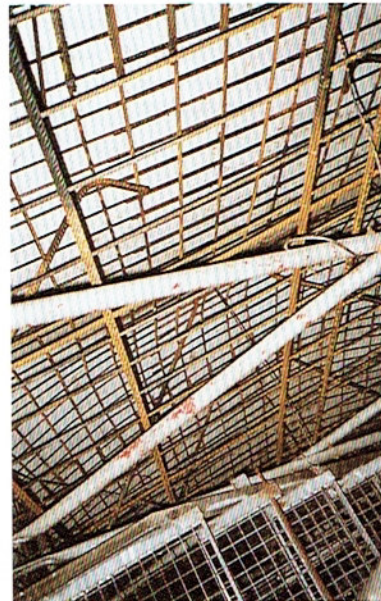
Bild 10: Statische Bewehrung und Netzbewehrung
