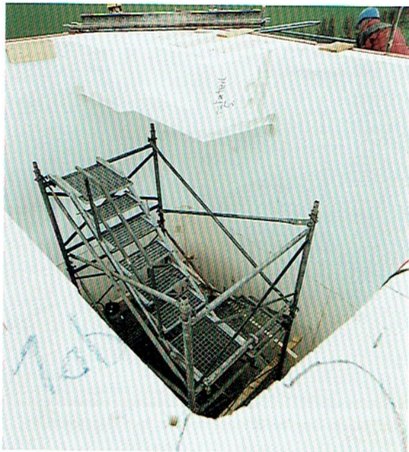
Bild 6: Teilmontierte Schalung und innen stehender Treppenturm
