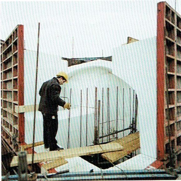
Bild 7: Schalung mit Styroporformen im Kopfbereich
