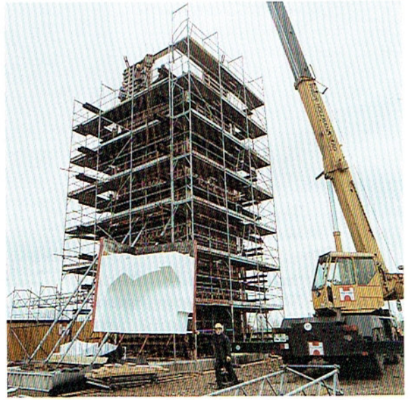
Bild 8: Schalungsturm mit Stahlaussteifung und Montieren eines Schalungselements
