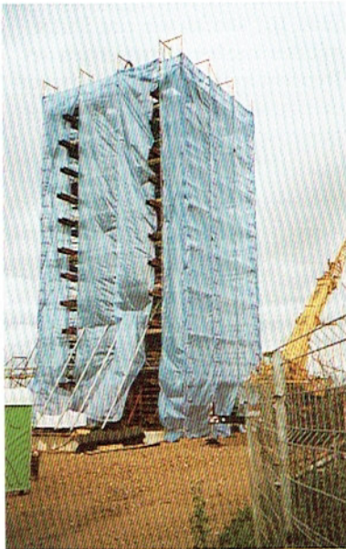
Bild 9: Zum Schutz gegen Witterungseinflüsse vollständig mit Folie eingehauster Turm
